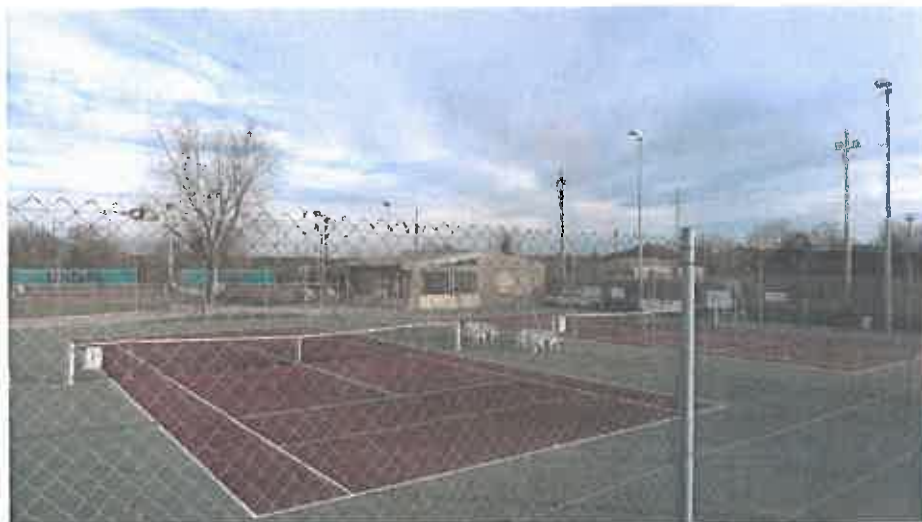
Réfection de l'éclairage public des tennis et régénération du revêtement des courts (juillet 2015 – montant des travaux : 16 005 € H.T.)
