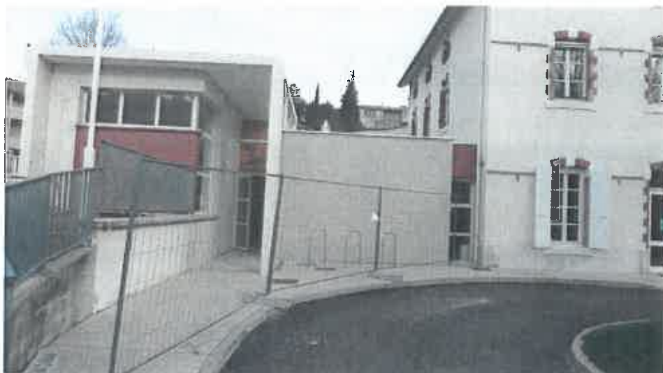
Extension de la crèche (fin 2015 – début 2016 – montant des travaux : 75 530,96 € H.T. honoraires de maîtrise d'œuvre compris)
